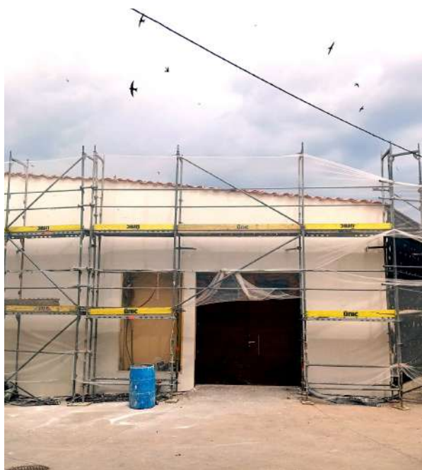
L'aïllament de façanes i obertures és bàsic per l'estalvi energètic
