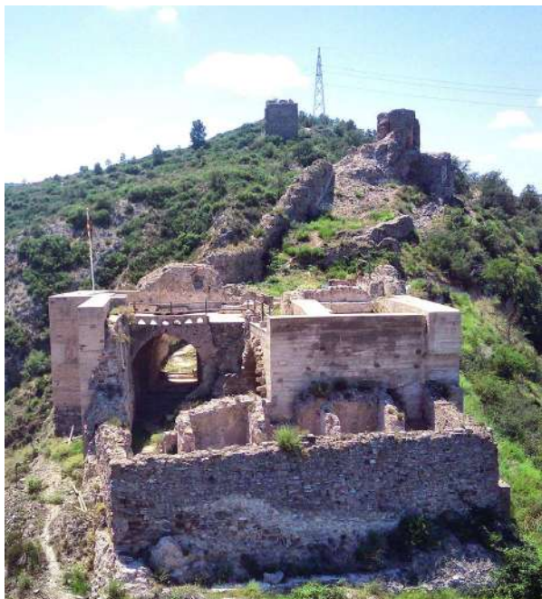
Vista del mur nord que es preveu restaurar pròximament (Ramon Sunyer)
