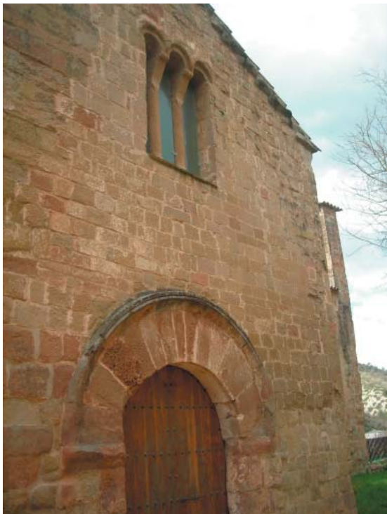
Priorat de Santa Maria
