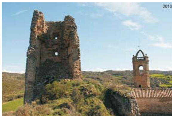
Vista general abans i després de la intervenció
