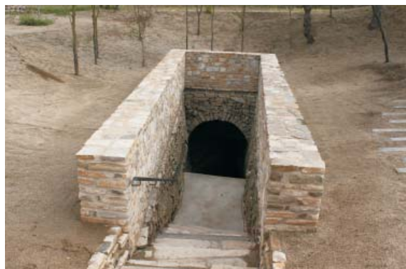
... i després de la rehabilitació
