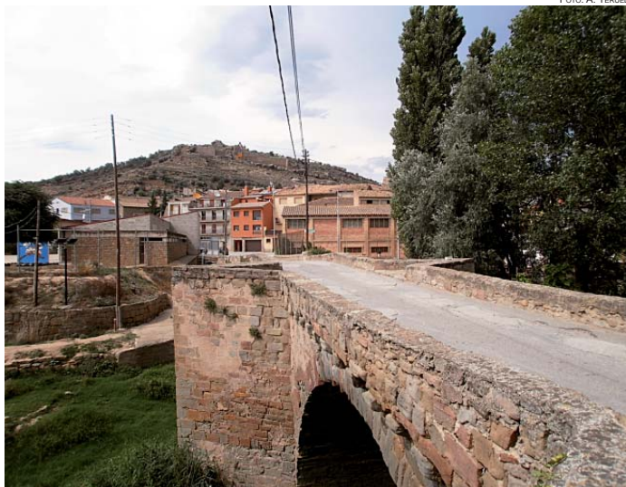
Sanaüja des del pont
