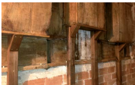
Detall de l'estructura del retaule
