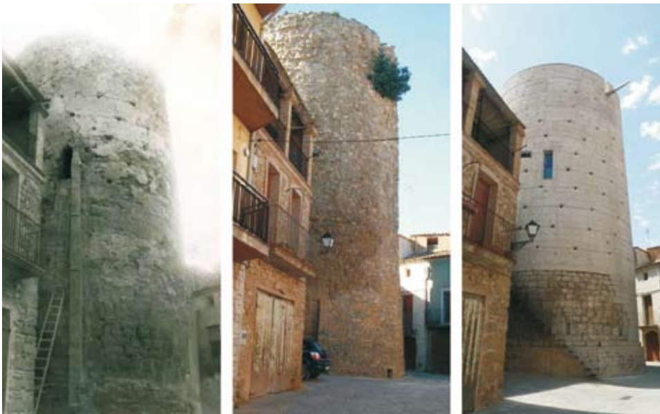
Sobre el sòcol medieval primigeni de pedra arenisca, tres moments de la història de la torre: 1930, amb l'acabat superficial erosionat generat directament pels negatius dels encofrats circulars que conformen el cos superior de morter i formigó de guix i el dipòsit d'aigua al seu interior. Després de 1980 amb el parament repicat rugós i el contrafort inferior. 2016, imatge d'aquesta darrera restauració.
