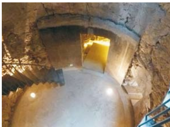
Espai interior del segon nivell on es va situar el dipòsit municipal d'aigua pels volts dels anys 1930 amb les noves escales d'accés a coberta.
