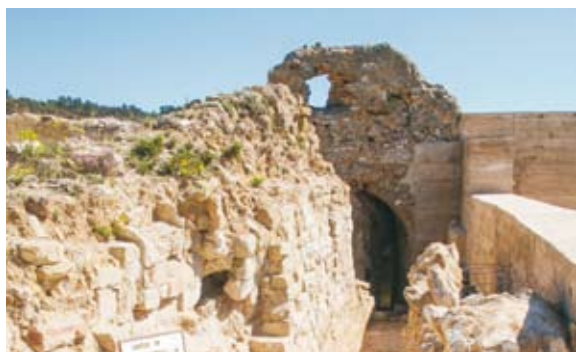
Passadís amb el mur de contenció, paret de l'església i mur de contrafort adossat a la muralla
