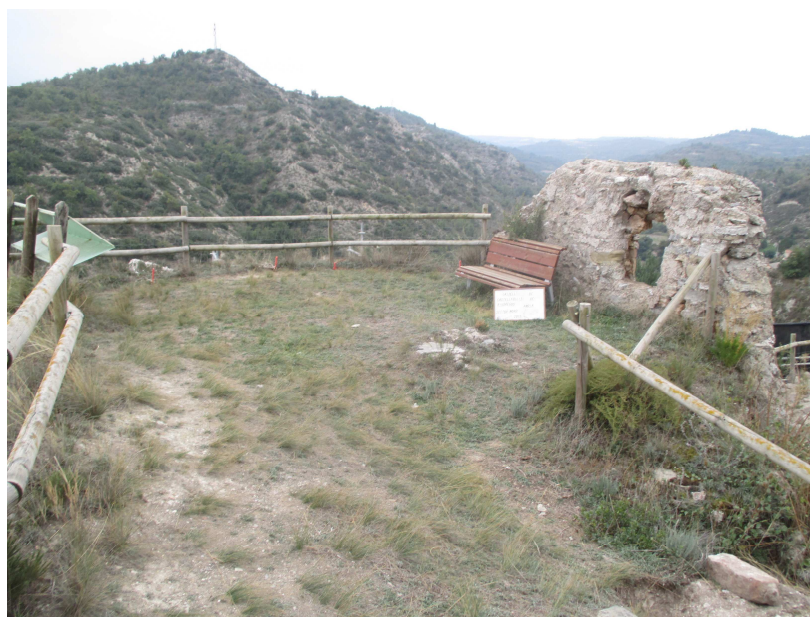
Estat inicial zona torre a consolidar.
