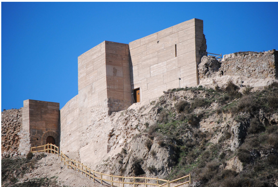
Restauració de la torre de la muralla i els portal
