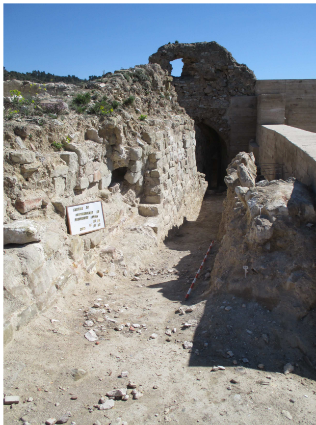
Passadís amb el mur de contenció paret església i mur de contrafort adossat a la muralla.
